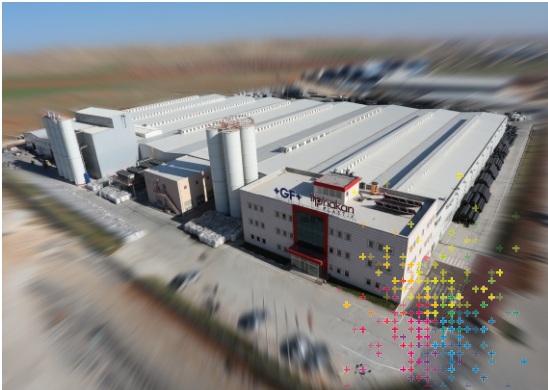
Georg Fischer Hakan Plastik Şanlıurfa Üretim Tesisleri
