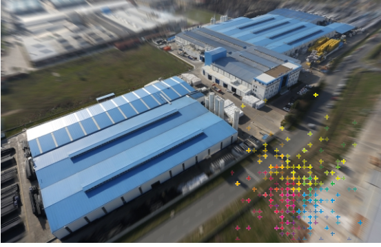
Georg Fischer Hakan Plastik Çerkezköy Üretim Tesisleri
