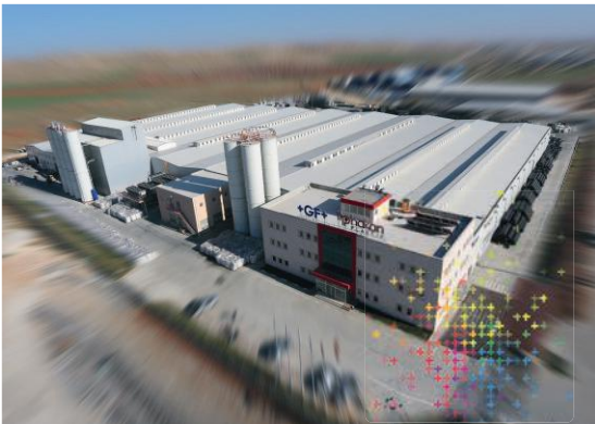
Georg Fischer Hakan Plastik Şanlıurfa Üretim Tesisleri
